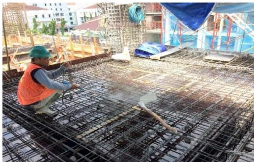
Gambar 4.15 pembersihan debu pekerjaan plat lantai.
