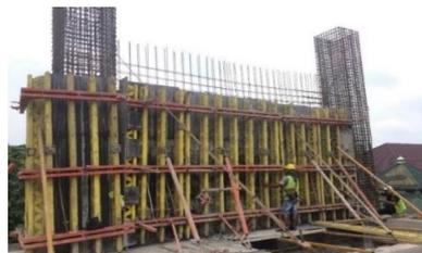
Gambar 4.17 Pekerjaan Pemasangan Bekisting *Shear Wall*.
