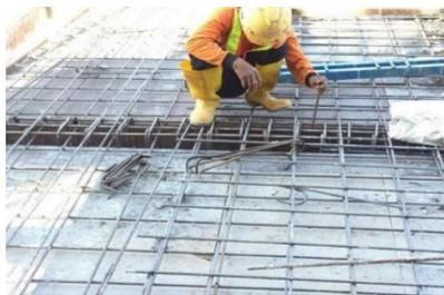
Gambar 4.11 Pekerjaan pemasangan tulangan balok.
