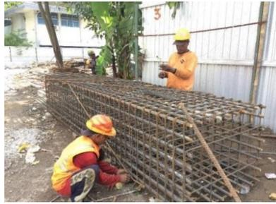
Gambar 4.8 Pekerjaan Membuat Rangkaian Tulangan Kolom.
