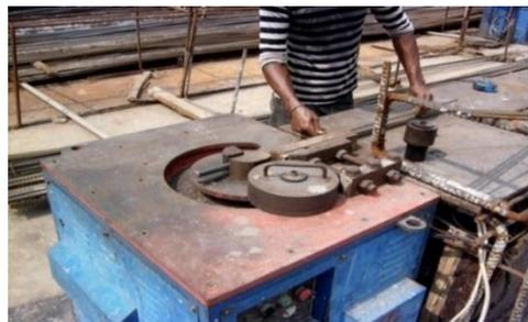
Gambar 4.7 Pekerjaan pembengkokan tulangan dengan *Bar bender*.
