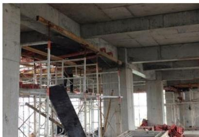
Gambar 4.13 Pekerjaan Pembongkaran Bekisting Balok.
