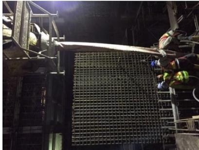
Gambar 4.18 Pekerjaan pengecoran *shear wall*.
