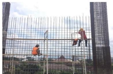
Gambar 4.16 Pekerjaan Penulangan pada *Shear Wall*.
