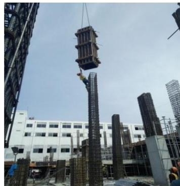
Gambar 4.9 Pekerjaan Pemasangan Bekisting Kolom.
