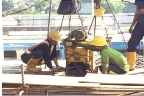
Gambar 4.6 Pemotongan tulangan dengan *Bar Cutter*.
