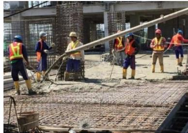
Gambar 4.12 Pekerjaan Pengecoran Balok.
