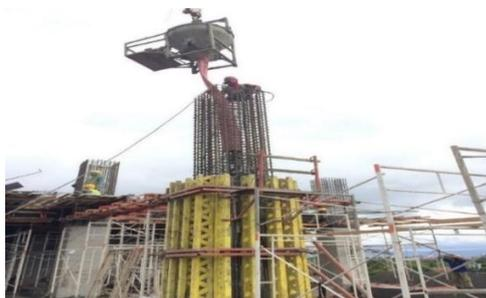
Gambar 4.10 Pekerjaan pengecoran kolom.
