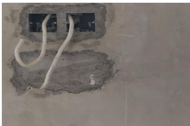
Gambar 4.13 Perubahan lokasi stopkontak
