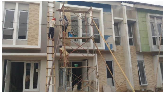
Gambar 4.15 Pengecatan bagian luar rumah
