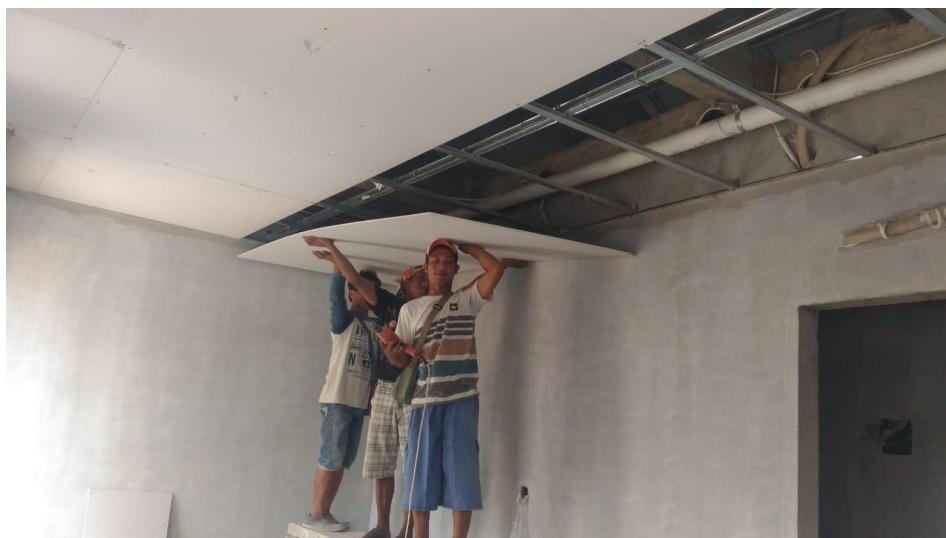
Gambar 4.8 Pemasangan plafond
