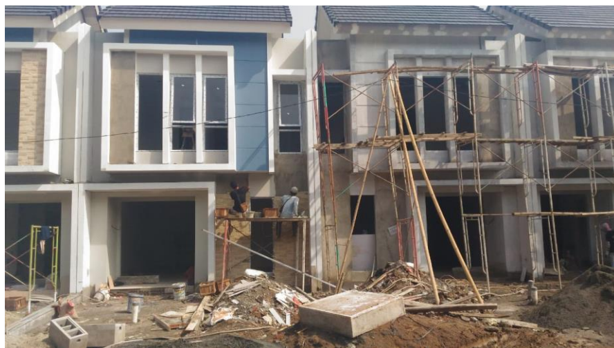
Gambar 4.18 Pemasangan batu alam
