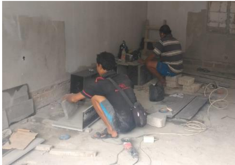
Gambar 4.11 Pemasangan marmer meja wastafel
