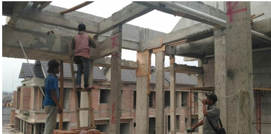
Gambar 4.3 Perbaikan pada beton yang keropos
