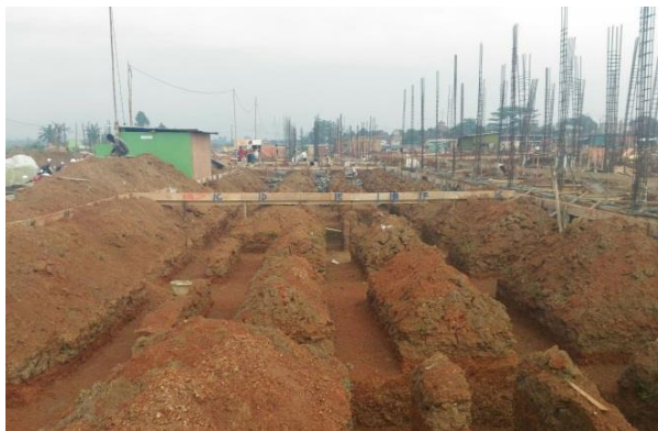
Gambar 4.1 Hasil pekerjaan bouwplank
