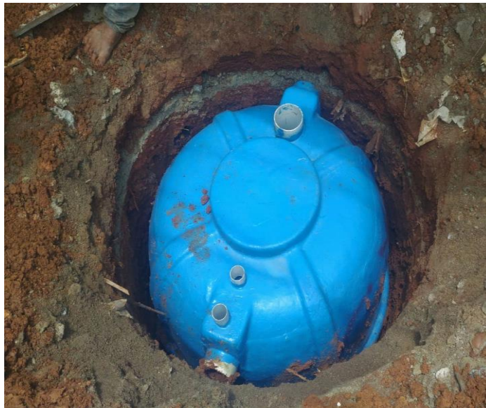
Gambar 4.16 Pemasangan septictank
