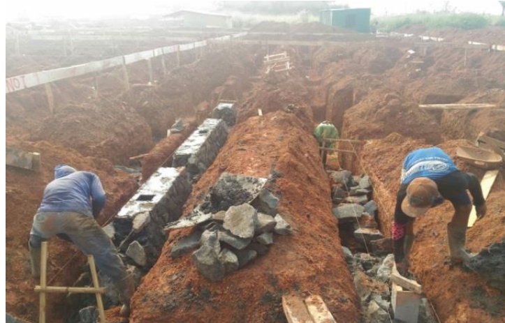
Gambar 4.2 Pemasangan pondasi batu kali
