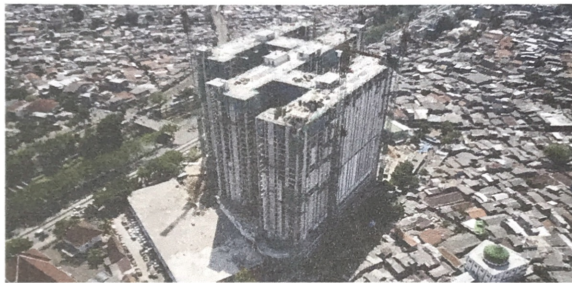
Gambar 5.2 Tampak bangunan dari arah barat daya
