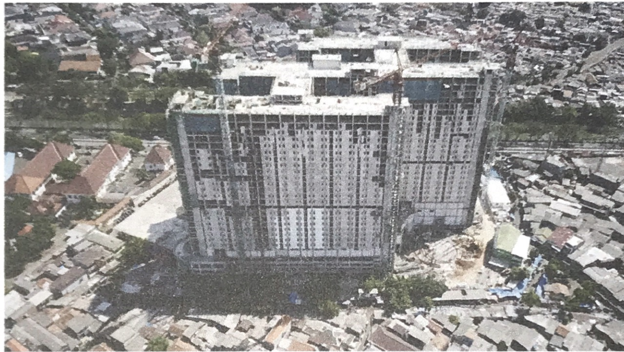
Gambar 5.5 Tampak bangunan dari arah selatan
