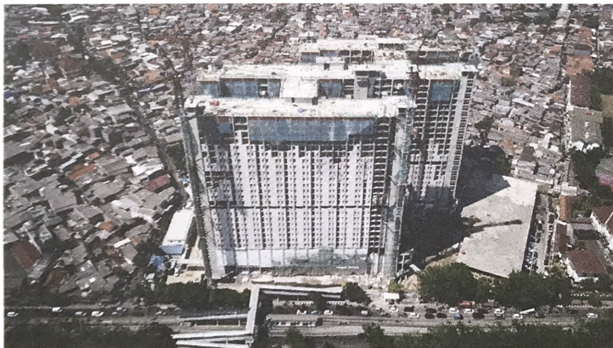
Gambar 5.9 Tampak bangunan dari arah utara
