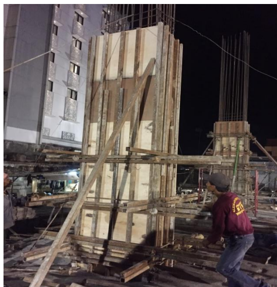
Gambar 4. 7 Pekerjaan kolom basement
