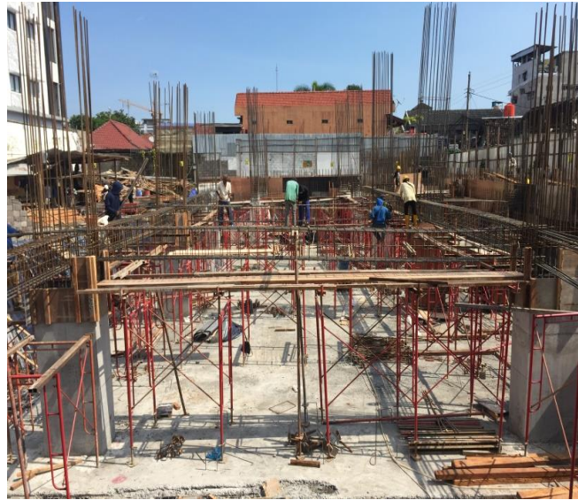
Gambar 4. 8 Pekerjaan balok basement
