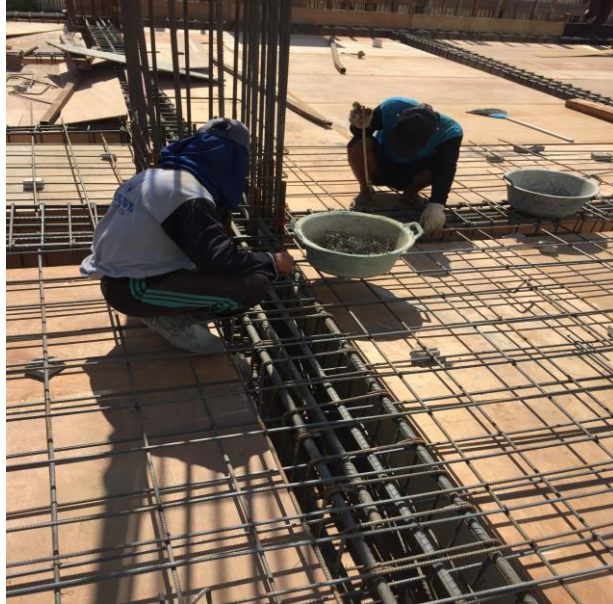
Gambar 4. 9 Pekerjaan pelat basement
