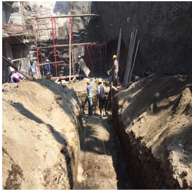
Gambar 4. 5 Pekerjaan galian pondasi raff
