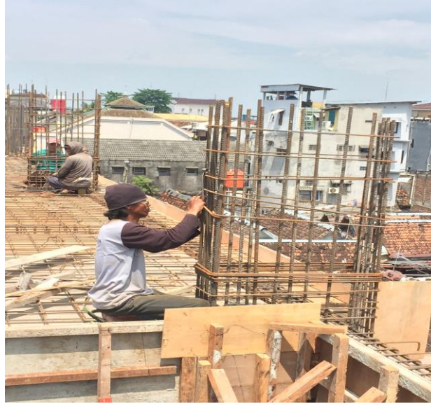
Gambar 4. 13 Pekerjaan kolom
