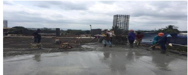
Gambar 4 Pemerataan Beton Segar Pekerjaan Pengecoran Proyek
