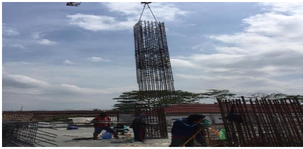
Gambar 3 Pengangkutan Tulangan Kolom Menggunakan TC Proyek
