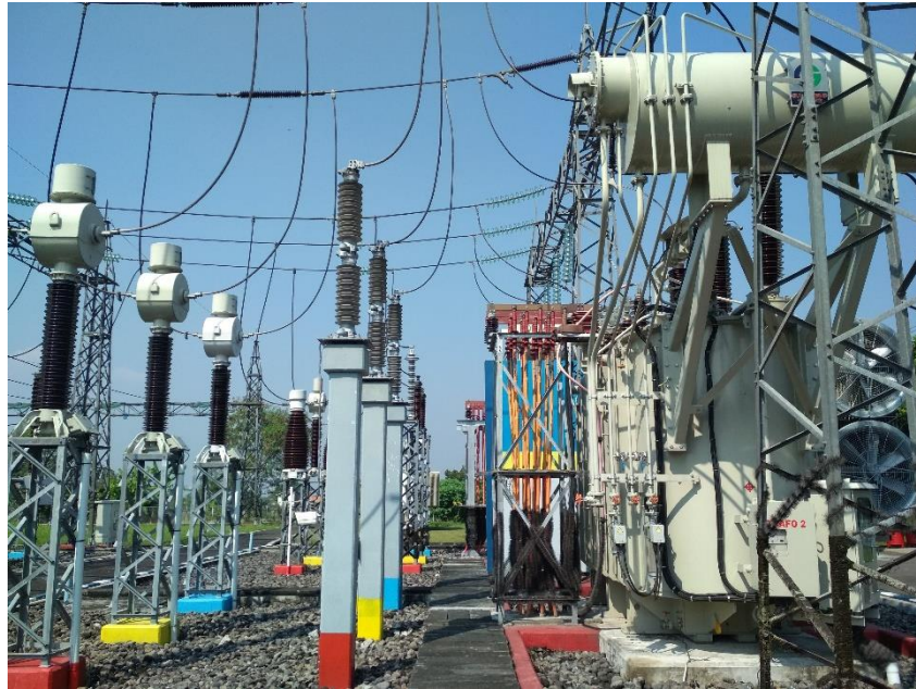
Gambar 4. 5 Jarak penempata LA dan Transformator
