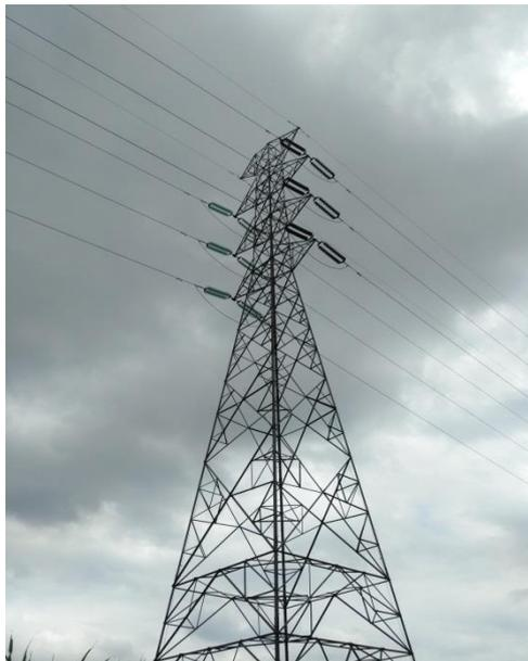
Gambar 2.1 Saluran Udara Tegangan Tinggi (SUTT)
