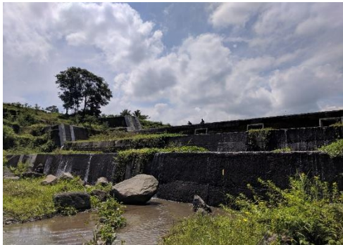
Gambar 15 Sabo dam dengan kode SD13 di Desa Jumoyo
