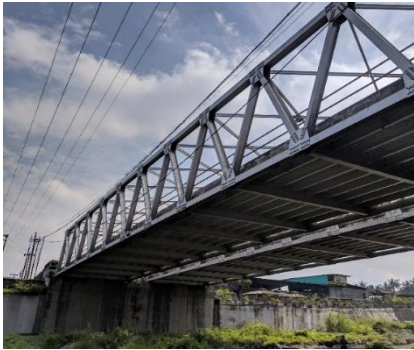
Gambar 12 Jembatan rangka baja di Jalan Magelang
