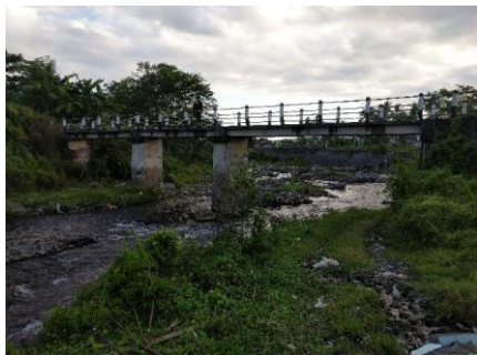
Gambar 13 Jembatan beton di Desa Sirahan
