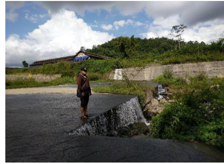
Gambar 14 Groundsill di Desa Gulon
