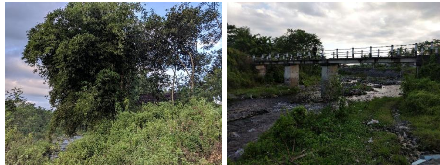
Sempadan Sungai – Jembatan JP07
