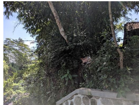
Sempadan Sungai – Jembatan JP11
