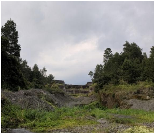
Bangunan Sabo Dam SD01
