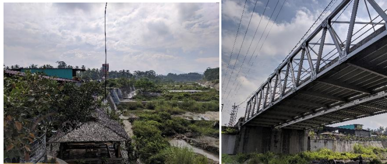
Sempadan Sungai – Jembatan JP06
