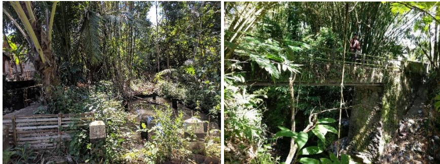
Sempadan Sungai – Jembatan JP10
