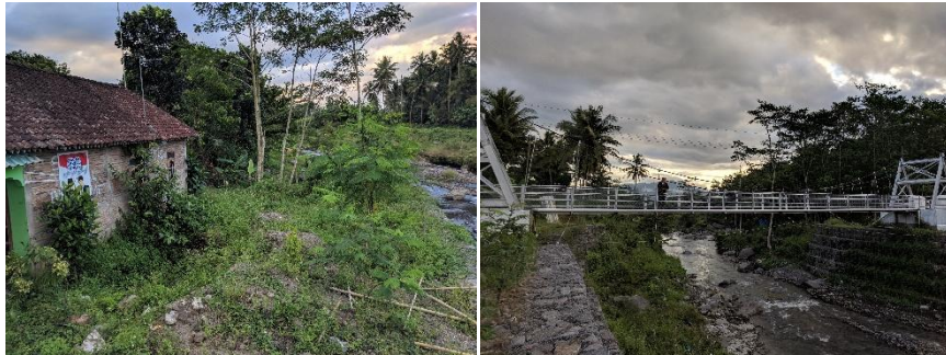
Sempadan Sungai – Jembatan JP08
