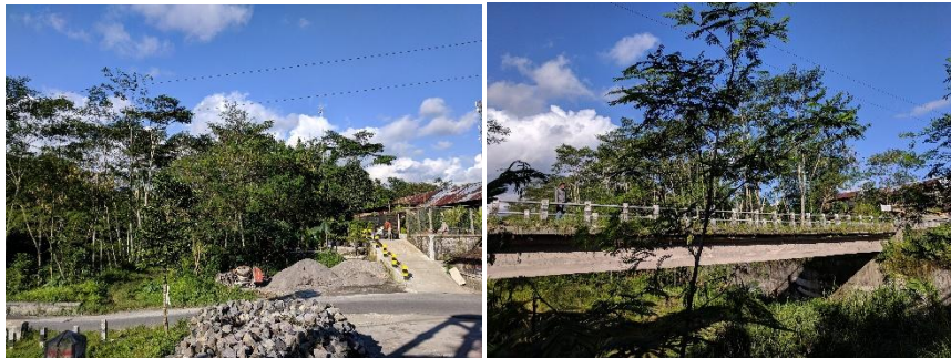
Sempadan Sungai – Jembatan JP02
