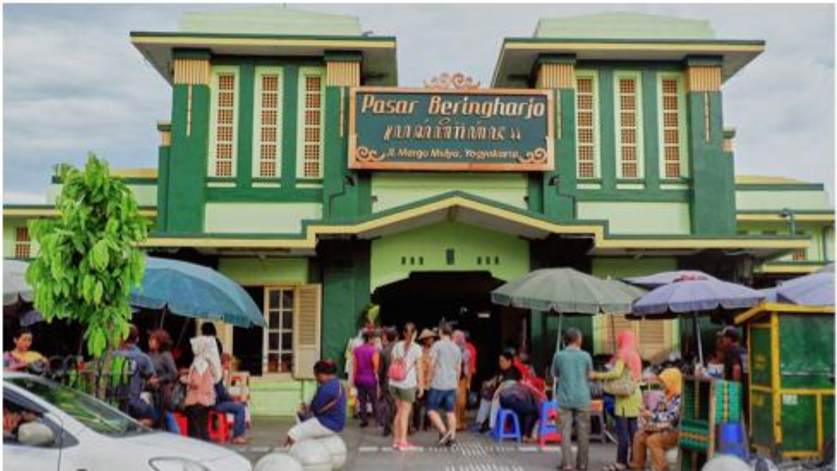
Gambar 4.1 Profil Gedung Penelitian
