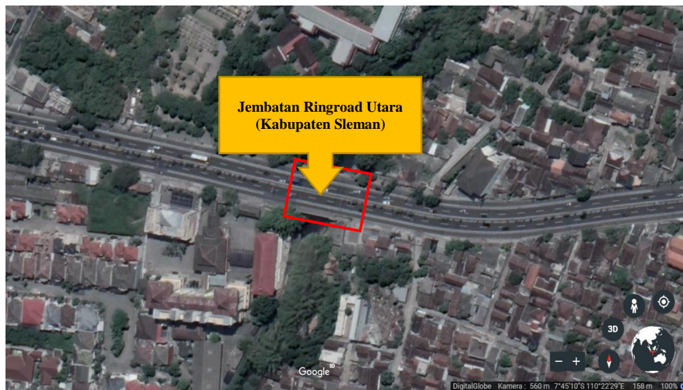
Gambar 3.3 Lokasi Jembatan Ring Road Utara (Kabupaten Sleman)
