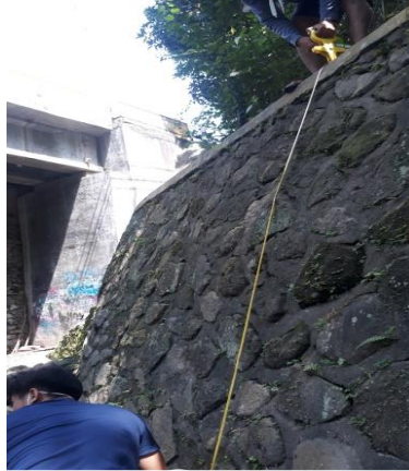
Gambar 3.24 Pengukuran tinggi penampang pada Sungai Code
