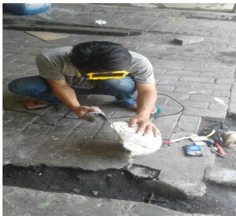
Gambar 3.29 Pemotongan Dengan Gerinda
