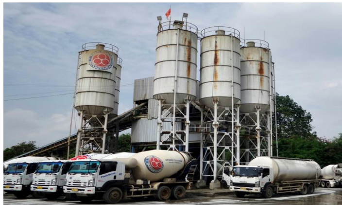
Gambar 2.1 Pabrik Beton Siap Pakai ( Ready Mix )
