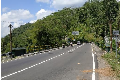
JP01 (Jembatan Klangon di Jalan Nanggulan-Mendut)
