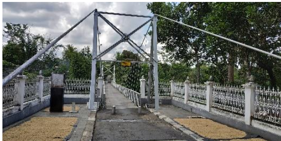
JP03 (Jembatan Gantung Duwet)
