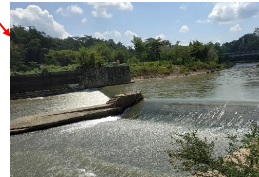
BP01 (Bendung Ancol Kalibawang)
