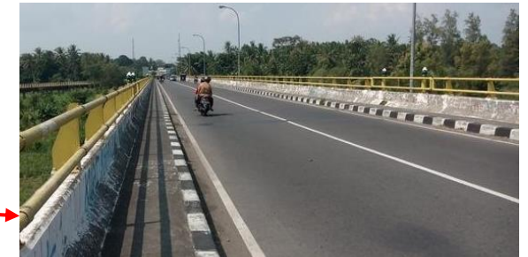
JP10 (Jembatan Srandakan)
