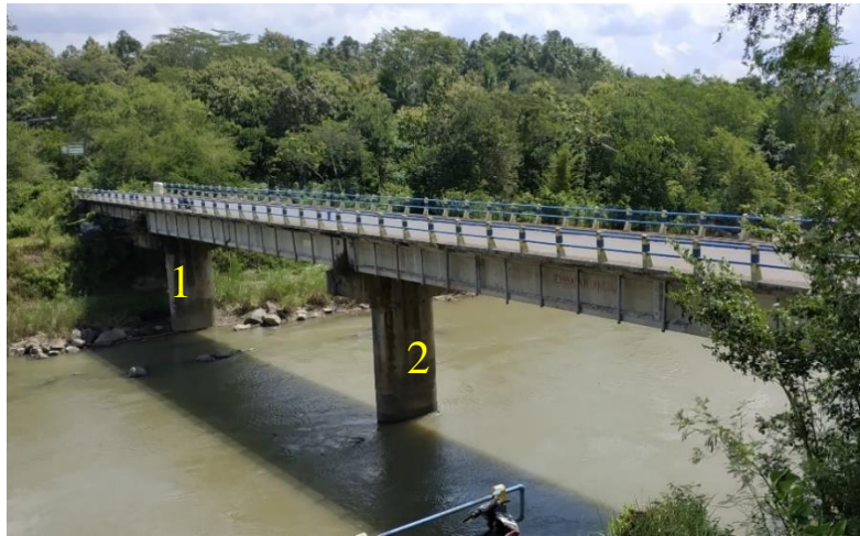
Gambar 4.34 Pilar jembatan Ancol
