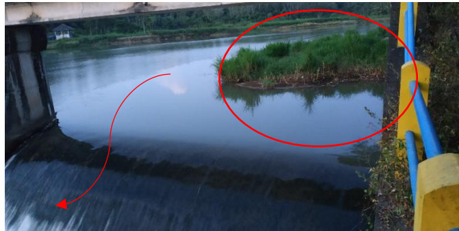
Gambar 4.66 Sedimentasi pada hulu bendung
