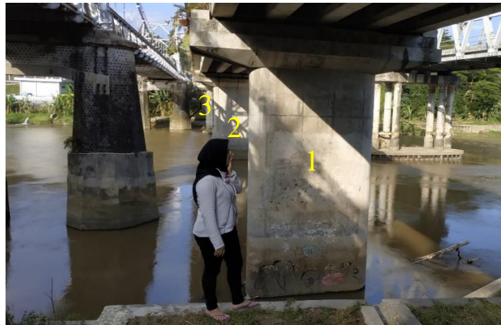
Gambar 4.55 Pilar jembatan Bantar I
