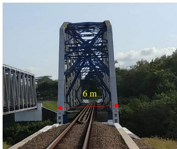
Gambar 4.49 Jembatan KA Mbeling I
