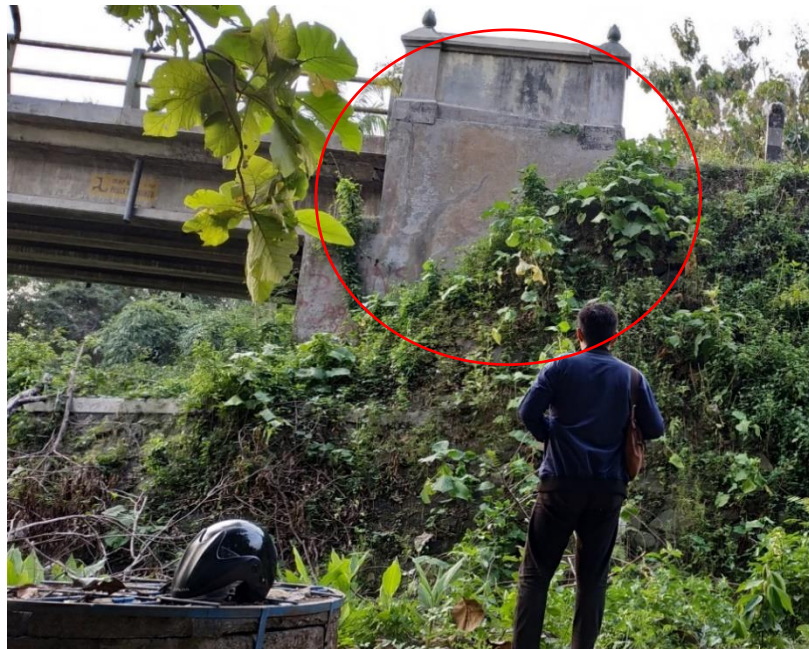
Gambar 4.45 Abutment jembatan Ngapak (Kebon Agung I)
