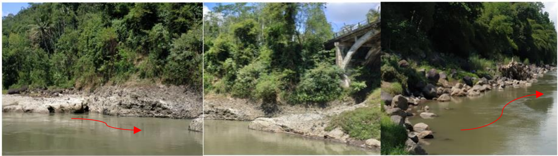
Gambar 4.30 Sedimen pada hulu, bawah dan hilir jembatan Klangon
