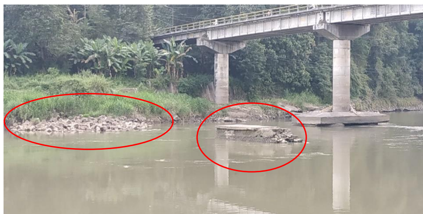
Gambar 4.47 Puing-puing bekas Groundsill
