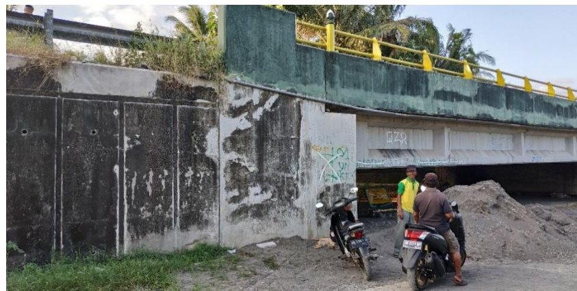
Gambar 4.62 Abutment jembatan Srandakan II
