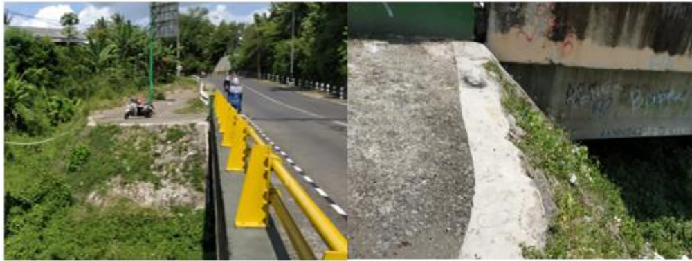
Gambar 4.40 Abutmen jembatan Kreo (Kebon Agung II)
