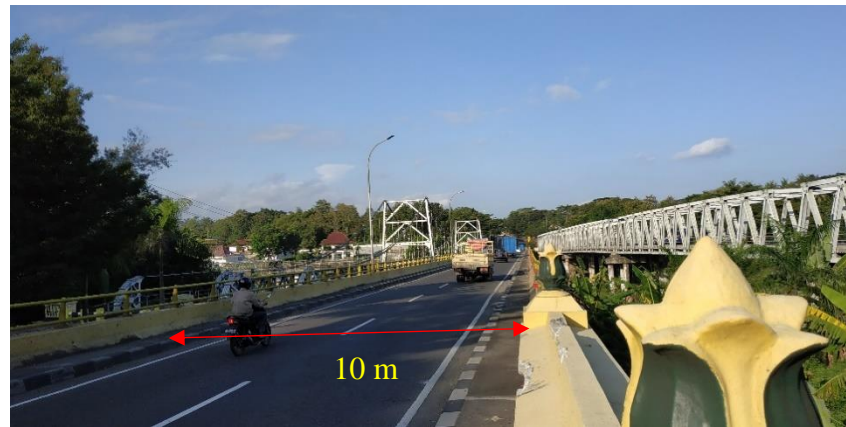
Gambar 4.54 Jembatan Bantar I
