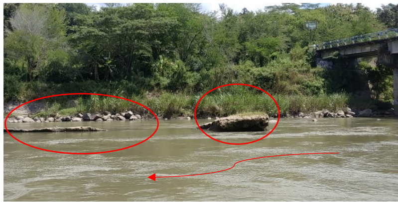
Gambar 4.35 Sedimen di hilir jembatan Ancol
