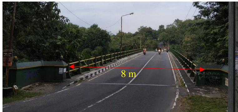
Gambar 4.43 Jembatan Ngapak (Kebon Agung I)
