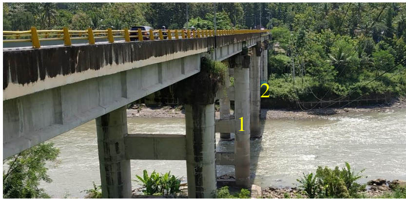
Gambar 4.41 Pilar jembatan Kebon Agung II
