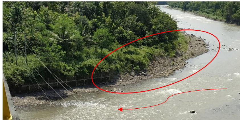
Gambar 4.42 Sedimen di sekitar jembatan Kreo (Kebon Agung II)
