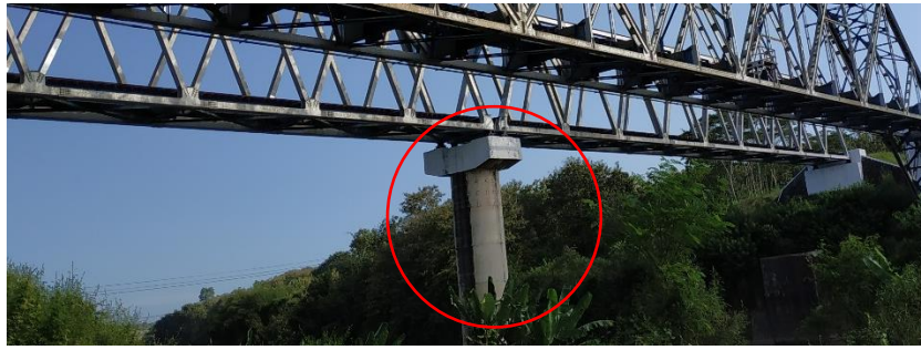
Gambar 4.52 Pilar Jembatan KA Mbeling II
