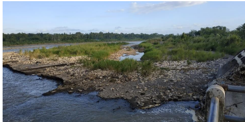
Gambar 4.63 Sedimen di sekitar jembatan Srandakan II
