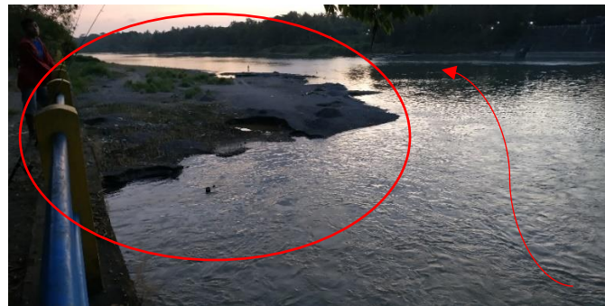
Gambar 4.67 Sedimentasi pada hilir bendung
