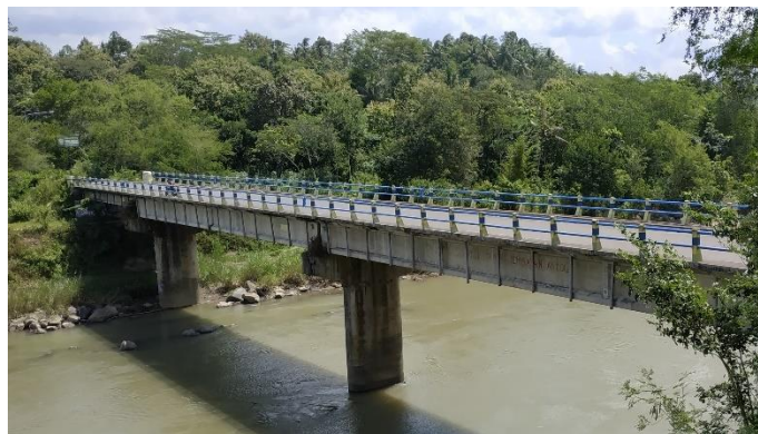
Gambar 4.22 Contoh jembatan beton
