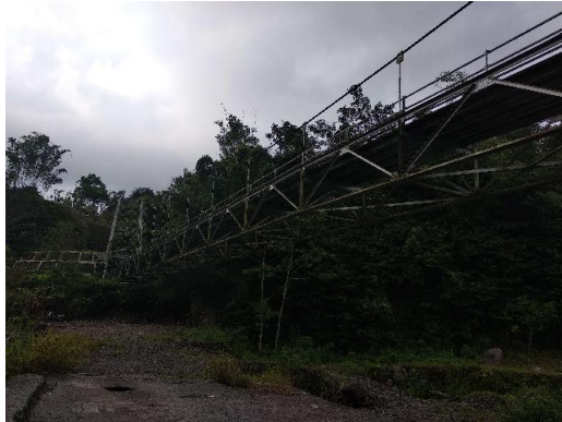
Jembatan rangka baja
