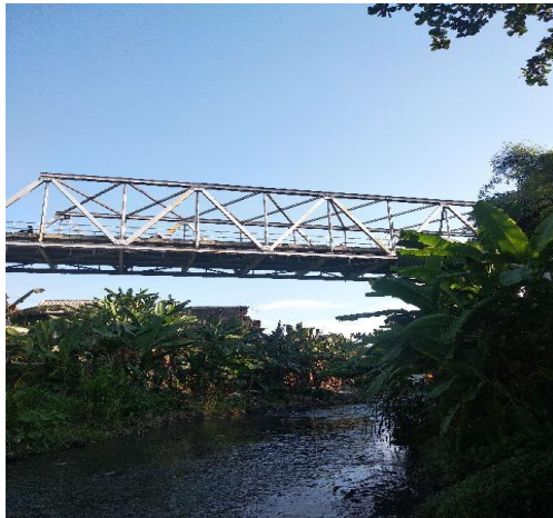
Jembatan rangka baja
