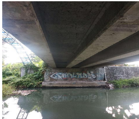
Tampak bawah jembatan
