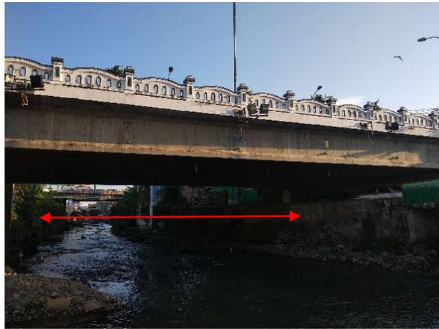
Gambar 4.28 Contoh jembatan tanpa pilar di badan sungai
