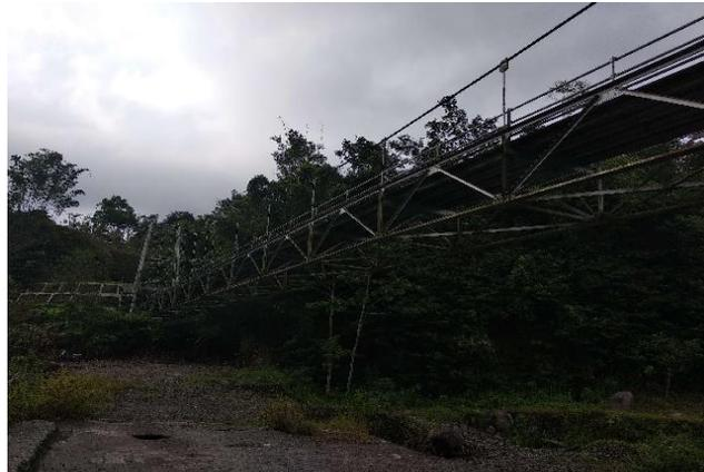
Gambar 4.25 Contoh jembatan rangka baja
