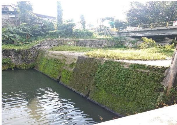
Gambar 4.22 Contoh bangunan non jembatan berupa *ground sill*
