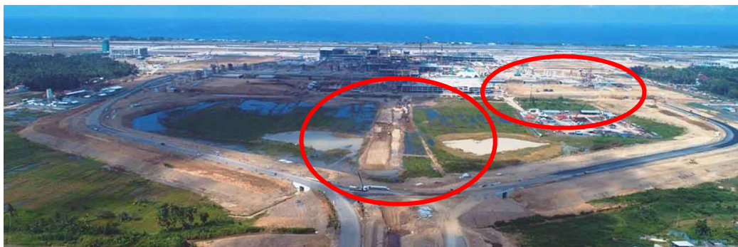
Gambar 3.2 Objek penelitian pada pekerjaan timbunan tanah
