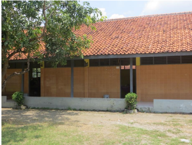
Gambar 4.2 Kondisi bangunan SLB Negeri Brebes
