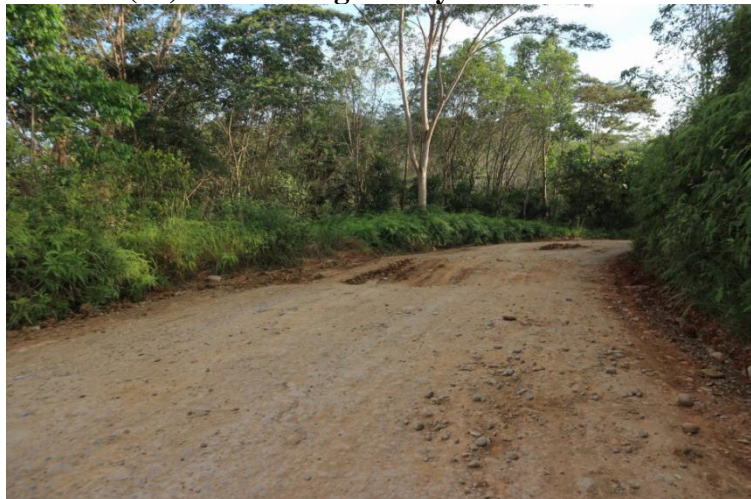
(11) Akses Jalan yang Rusak
