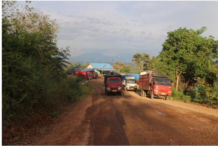
(9) Keadaan Jalan Akses Tambang Setelah di Siram
