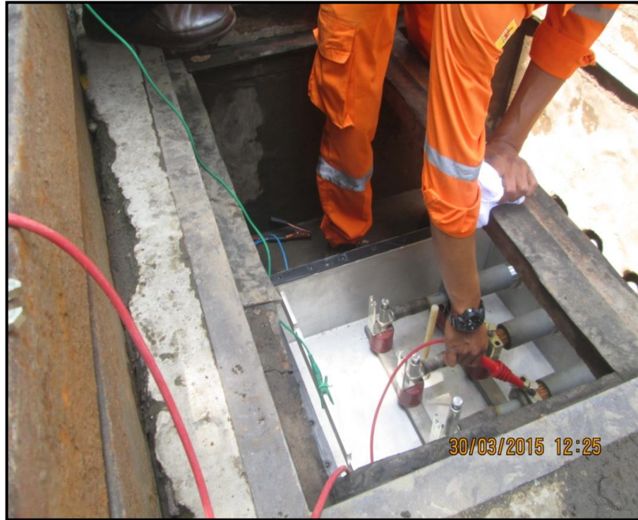
Gambar 2.15 Pengujian Tahanan isolasi Kabel
