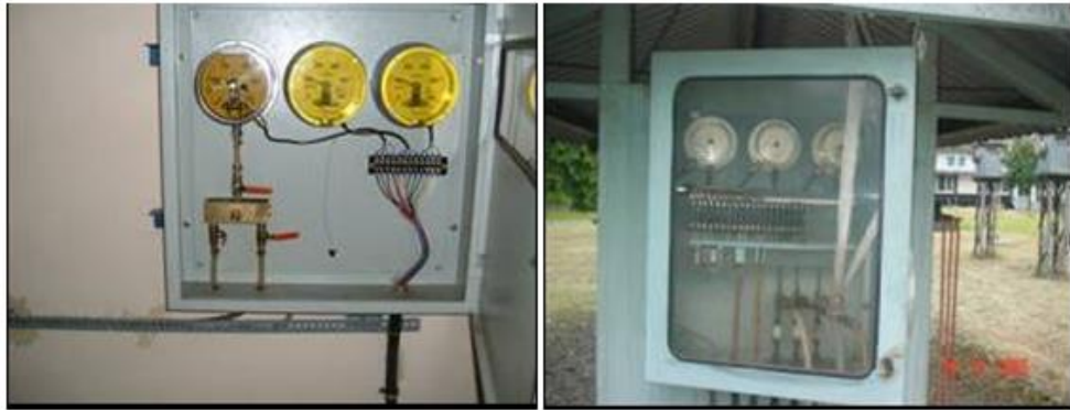
Gambar 2.12 Manometer tekanan minyak tangki
