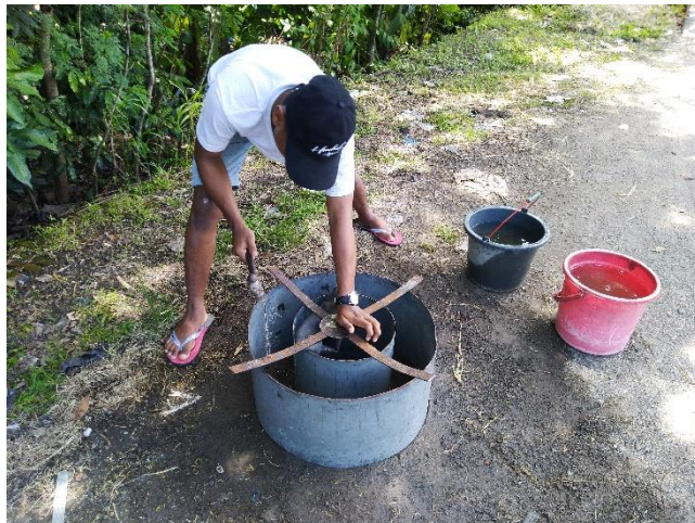
Gambar 2 Proses pemasangan alat
