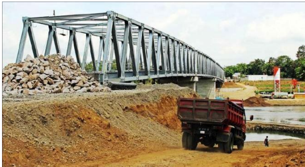
Gambar 1 Pembangunan Jembatan Rangka baja Ngadiluwih
