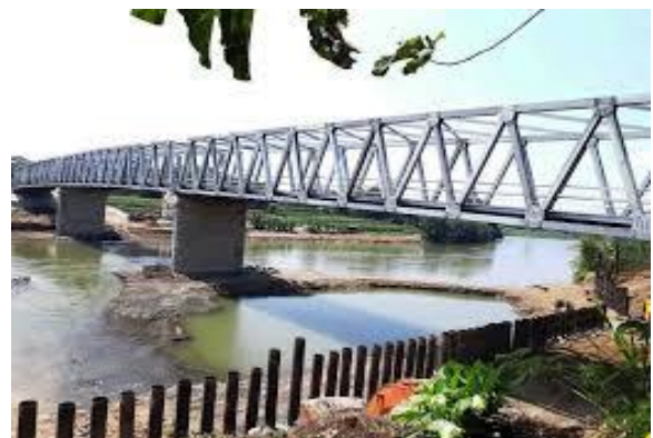
Gambar 2 Pembangunan Jembatan Rangka baja Ngadiluwih
