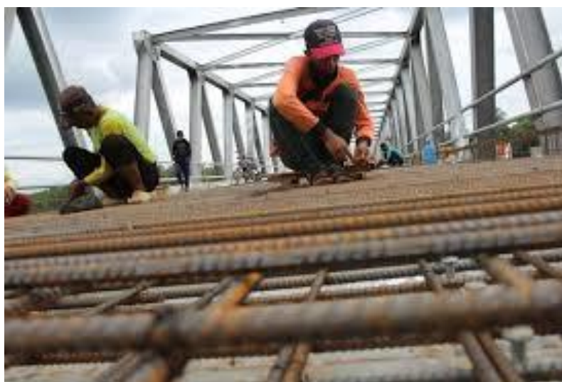
Gambar 4.30 Penulangan pada plat lantai jembatan
