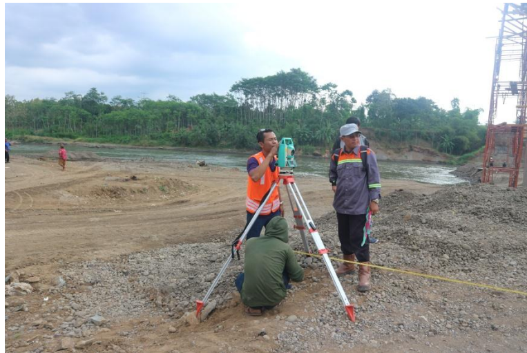
Gambar 4.8 Pengukuran dan Pematokan
