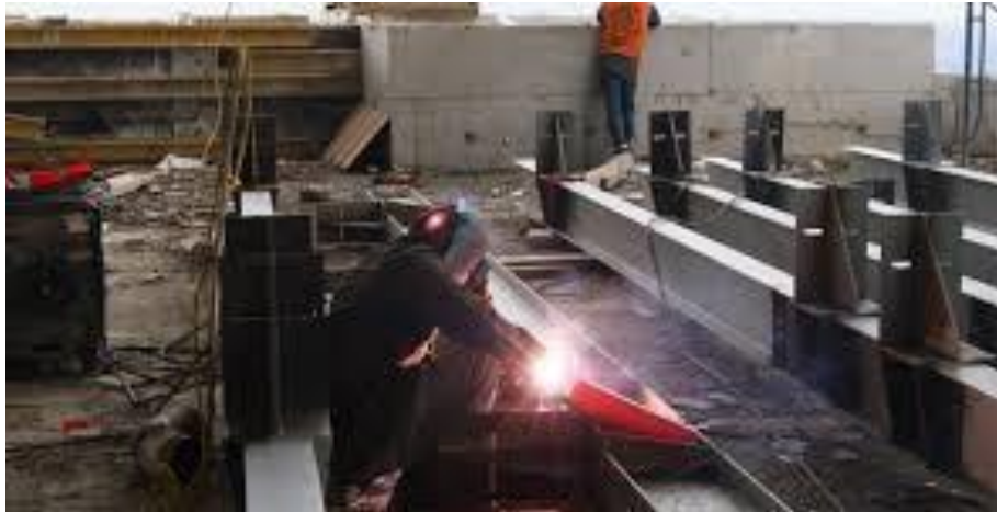
Gambar 4.27 Pekerjaan Pengelasan Baja di lapangan
