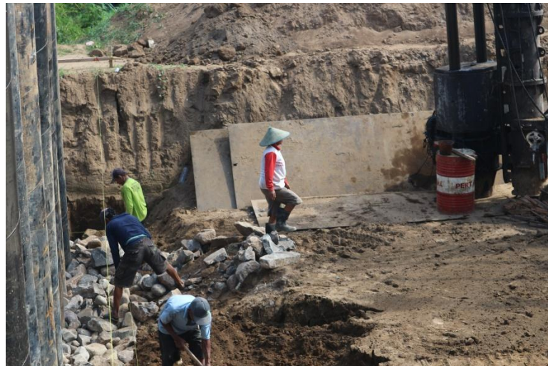
Gambar 4.13 Pekerjaan Pasangan Batu Lantai Kerja Jembatan
