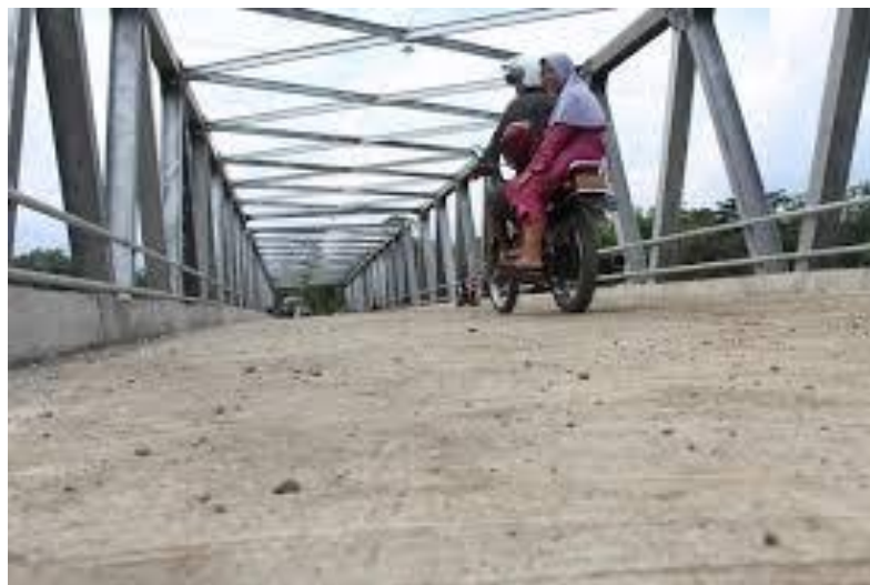
Gambar 4.31 Keadaan Plat lantai setelah pengecoran
