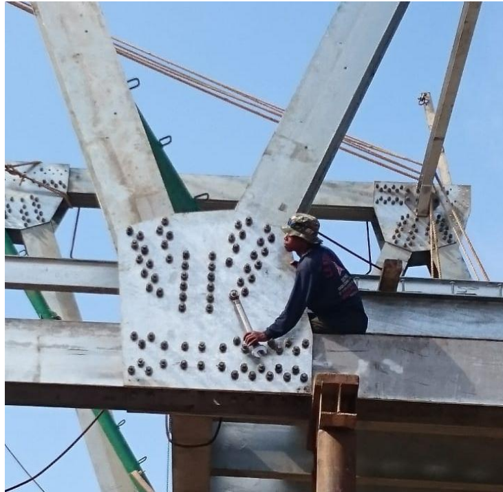
Gambar 4.24 Pemasangan Rangka Baja di Lapangan
