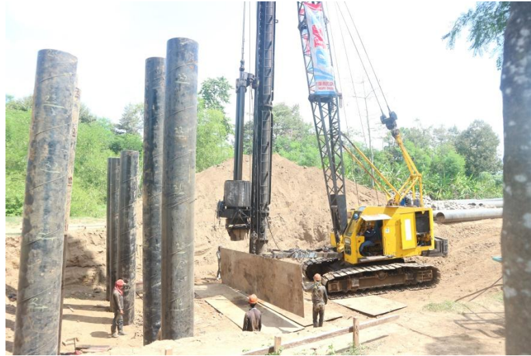
Gambar 4.12 Pemancangan Tiang Pancang Baja
