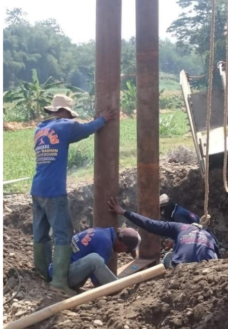
Gambar 4.22 Persiapan Rangka Baja
