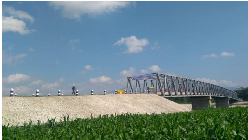
Gambar 4.1 Jembatan Ngadiluwih Kediri
