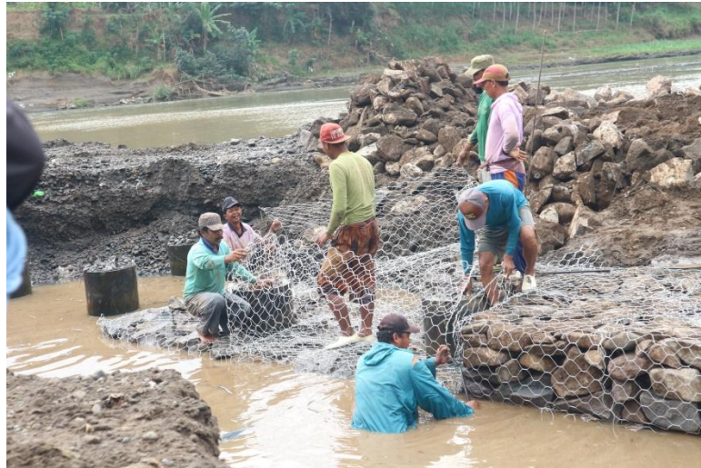
Gambar 4.7 Pekerjaan Pemasangan Bronjong
