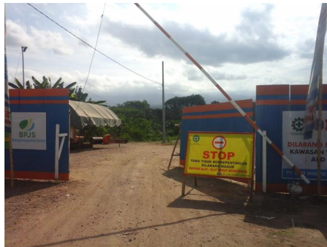
Gambar 4.4 Gerbang Masuk Lokasi Proyek
