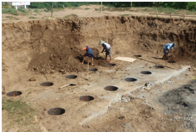
Gambar 4.16 Pekerjaan Lantai Kerja Jembatan
