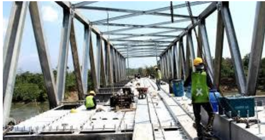
Gambar 4.26 Plat Lantai Jembatan
