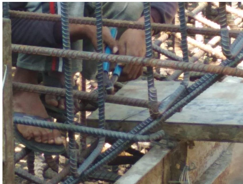
Gambar 4.18 pemasangan kawat bendrat pada tulangan
