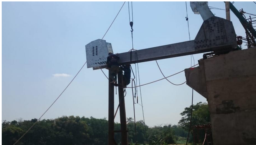
Gambar 4.23 Pemasangan Rangka Baja di lapangan
