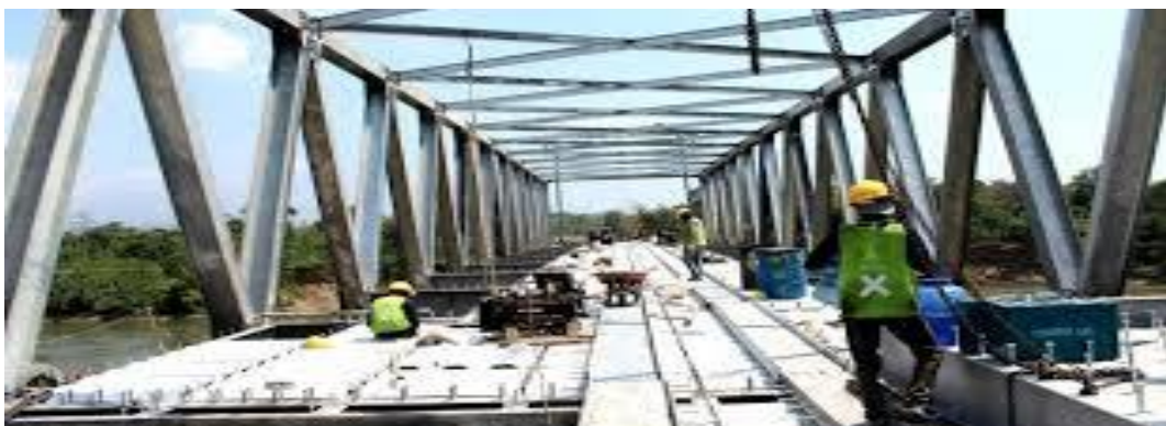
Gambar 4.29 Plat Lantai Jembatan
