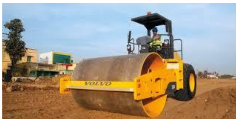
Gambar 4.11 Pemasatan Tanah dengan Vibrator Roller
