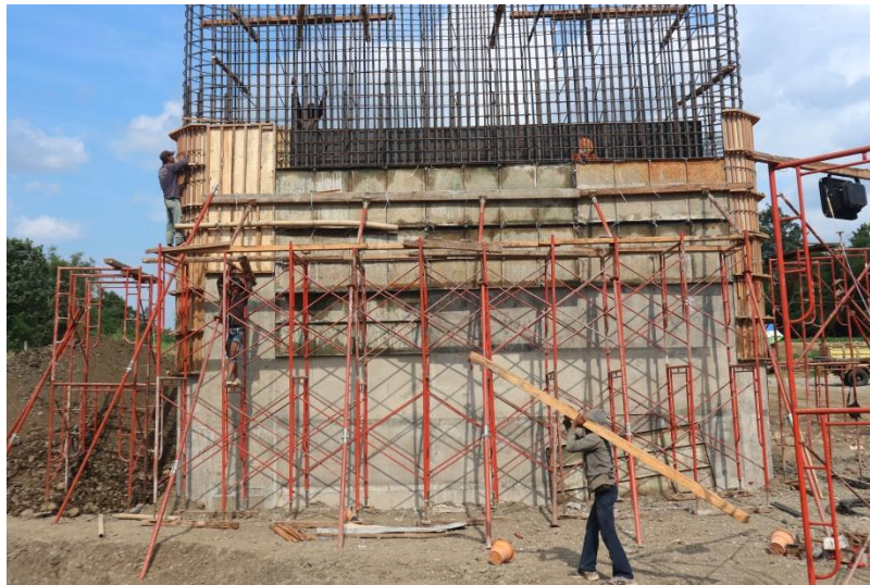
Gambar 4.19 Pemasangan Bekisting
