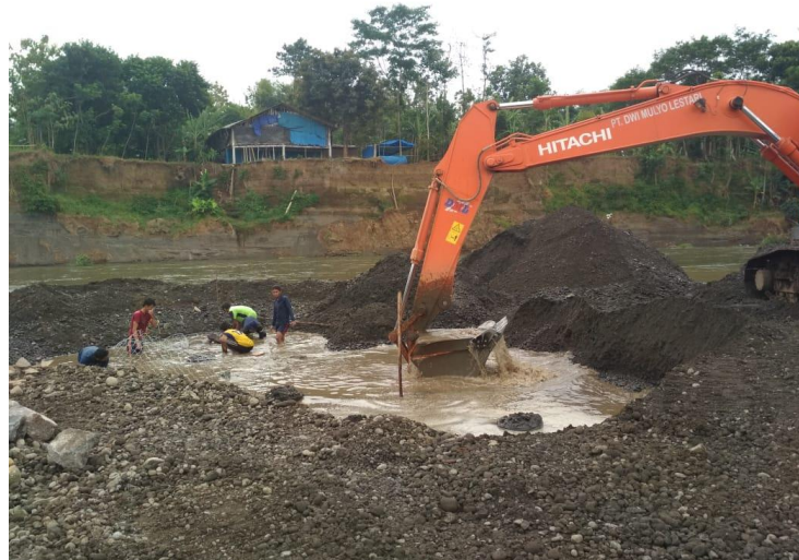
Gambar 4.6 Galian Untuk Pekerjaan Drainase
