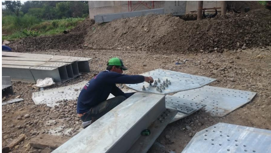
Gambar 4.25 Pemasangan Baut pada Rangka Baja
