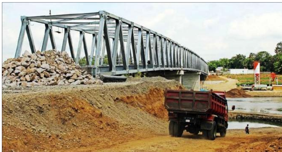
Gambar 2.1 Proses Pembangunan Jembatan Ngadiluwih
