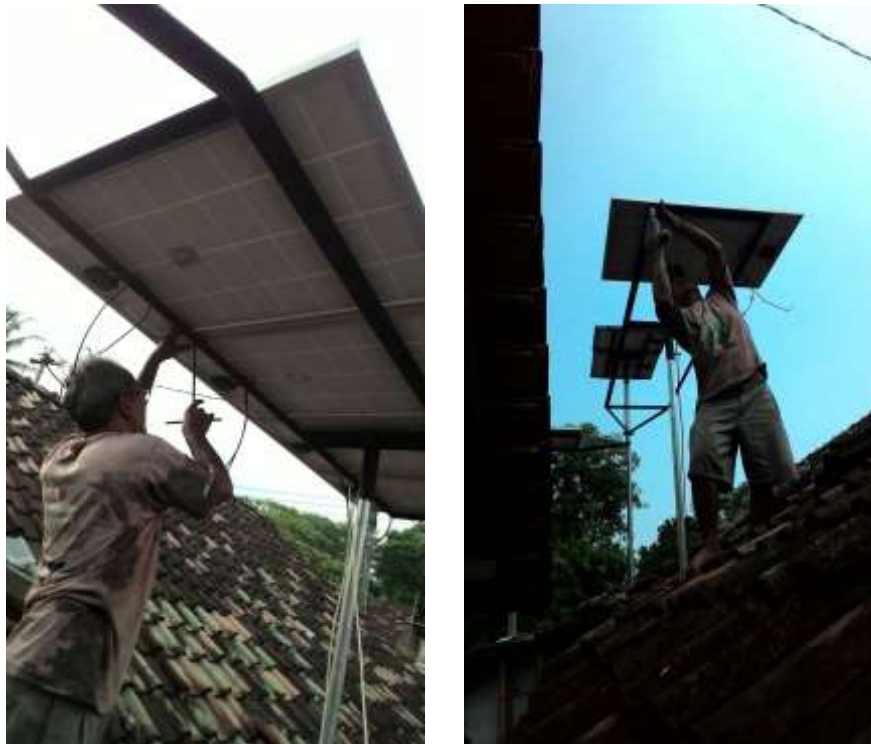
Gambar 5.9. Pemasangan perangkat solar home system di UKM Batik
