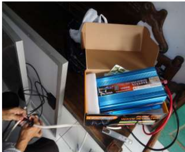
Gambar 4.1. Proses perakitan pembangkit listrik tenaga surya dengan inverter
