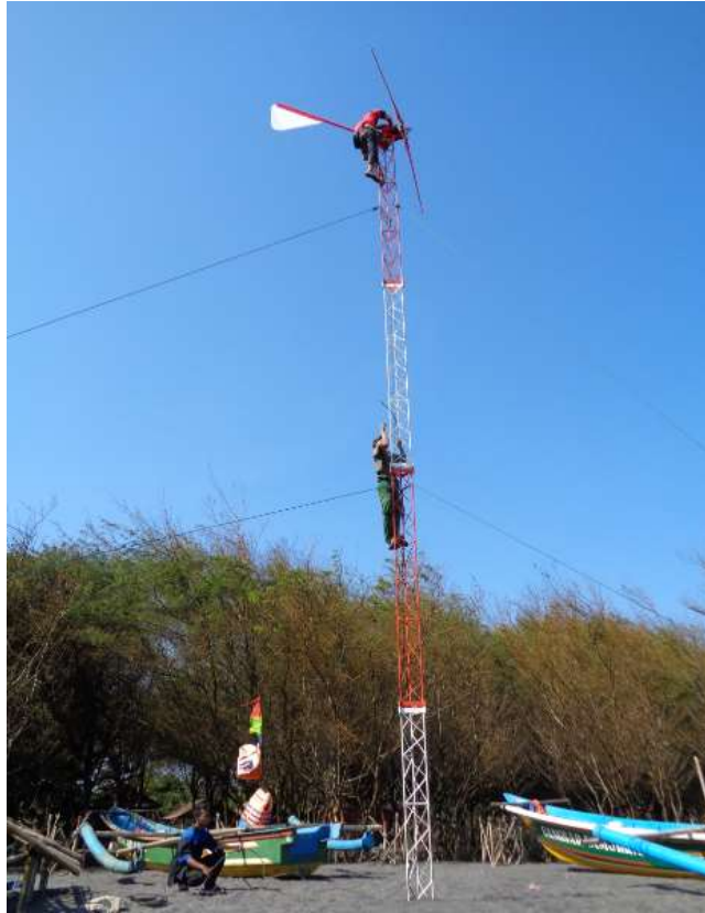
Gambar 4.3. Pemasangan wind turbine 2 kW di lokasi uji Pantai Baru, Bantul
