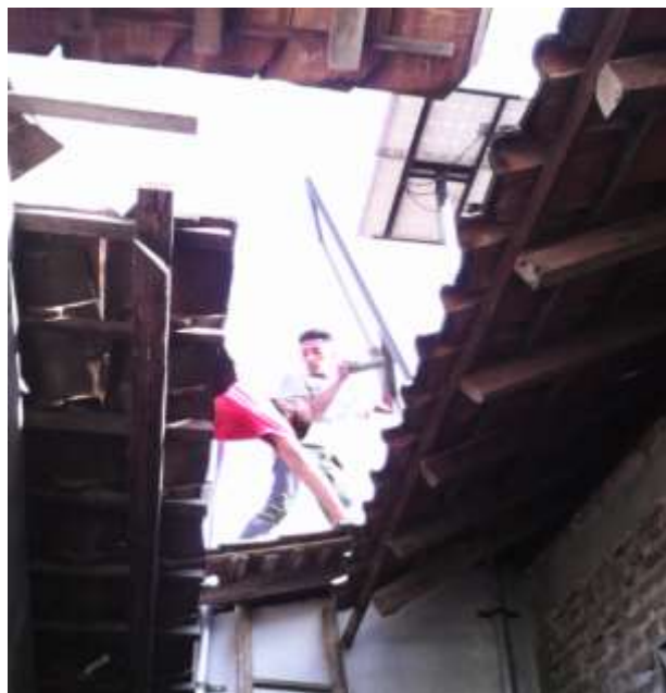
Gambar 4.2. Lanjutan proses pemasangan pembangkit listrik tenaga surya
