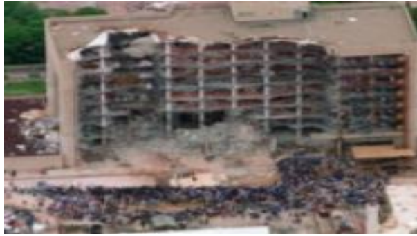
Gambar 2.7 Tipe keruntuhan campuran pancake -domino
