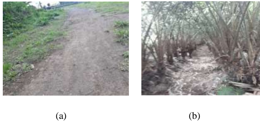
Gambar 25. Kondisi Akses/Jalan di Embung Kaliaji (a) Jalan disekitar embung, (b) Jalan kebun Salak
