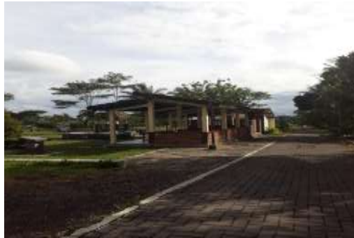
Gambar 13. Kondisi Saung di Embung Kaliaji
