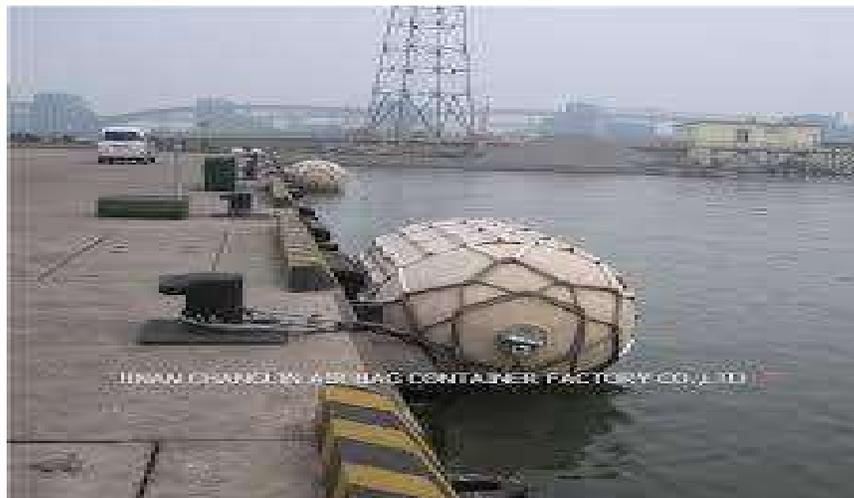
Gambar 2.6. *Fender* Karet Bentuk *Pneumatic*
