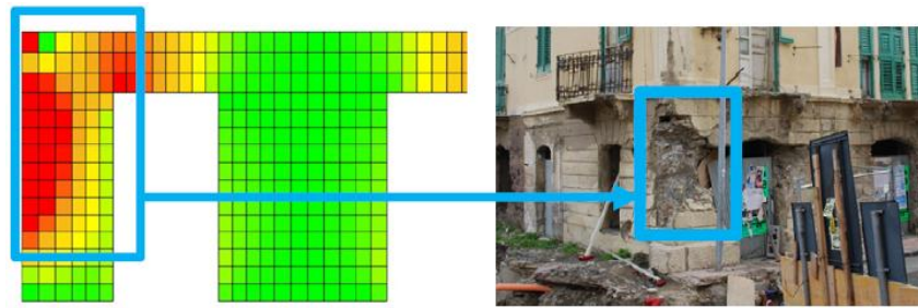
Gambar 2.6 Perbandingan antara hasil analisis dan kerusakan dinding utara (Jalayer, 2016)
