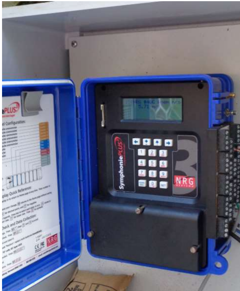
Gambar 5.7. Pemasangan anemometer untuk monitoring laju angin di lokasi pengujian untuk wind turbine 2 kW di Pantai Baru, Bantul
