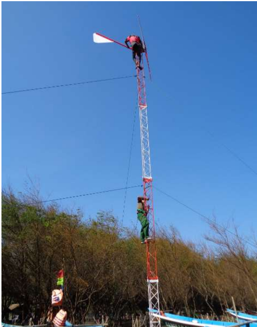
Gambar 5.6. Pemasangan wind turbine 2 kW (blade warna merah-putih) di lokasi uji Pantai Baru, Bantul
