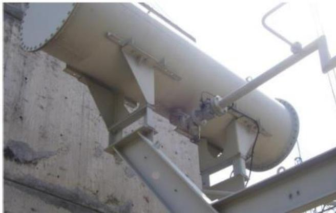
**Gambar 2.2.** Konservator minyak trafo
