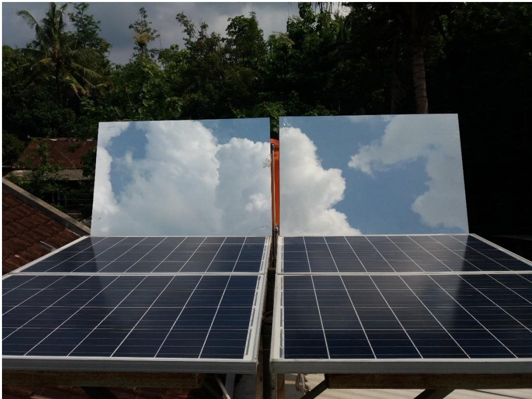
Pemasangan Reflektor Kaca
