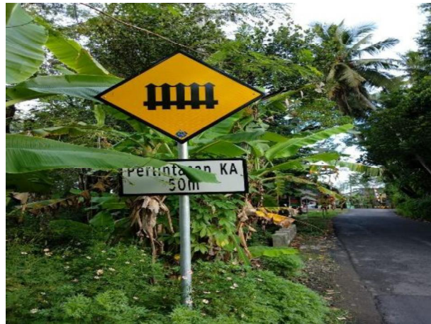
Gambar 4.1 Rambu peringatan perlintasan sebidang
