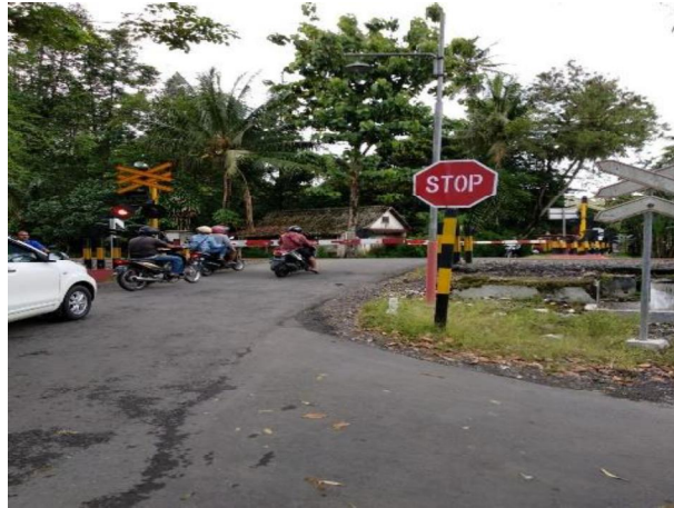
Gambar 4.11 Palang pintu perlintasan
