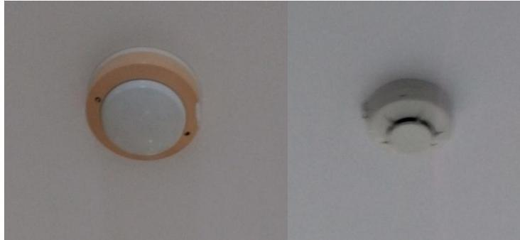
Gambar 4. 2 Sistem Detektor Panas (Kiri) dan Sistem Detektor Asap (Kanan)
