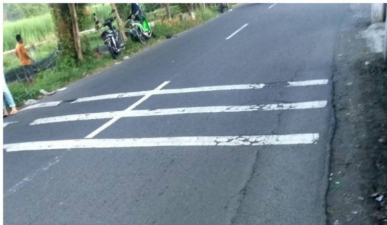
Gambar 4. 2 Pita Penggadu ( rumble strip )
