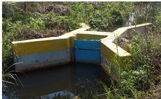
Gambar 3. Pintu air di saluran lahan pasang surut tipe B di lahan rawa pasang surut tipe B di KP Belandean (Dok:Ani S)
