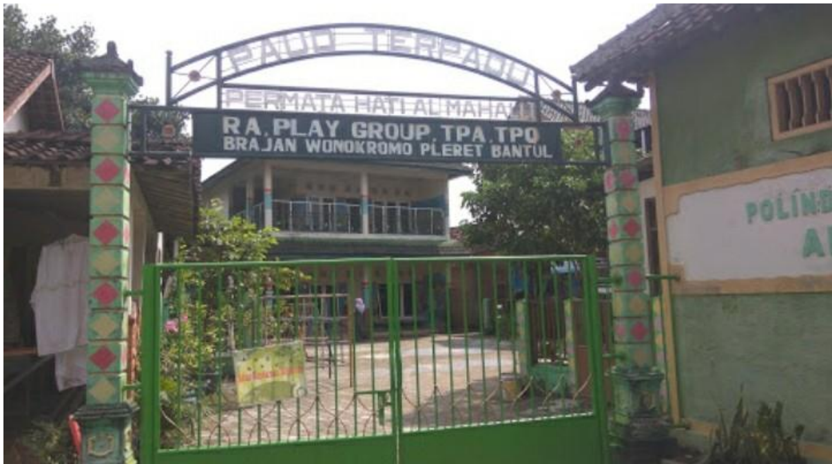
Bangunan PAUD dan TK Permata Hati AL – Mahalli
