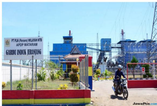
PLTU Jeranjang unit II yang belum beroperasi hingga saat ini. (SirtuLombok Post/JawaPos.com)
