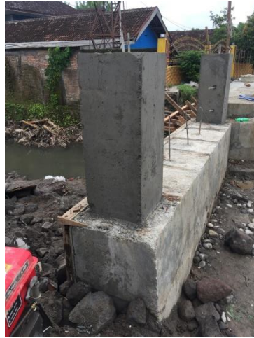
Gambar 4.12 Hasil pengecoran loneng
