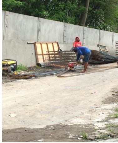
Gambar 4.9 Perakitan tulangan yang hanya menggunakan satu alat
