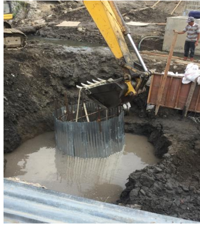
Gambar 4.11 Penurunan dinding sumuran yang terendam air
