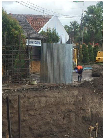
Gambar 4.10 Pemasangan dinding pondasi sumuran
