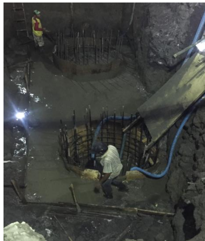
Gambar 4.12 Proses pengecoran dibantu diesel untuk mengeluarkan air
