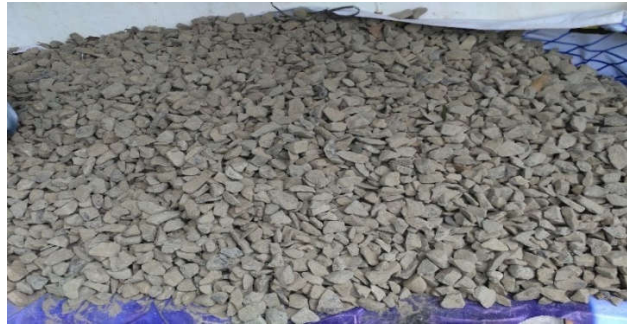
Gambar 3.6 Agregat kasar untuk material balas
