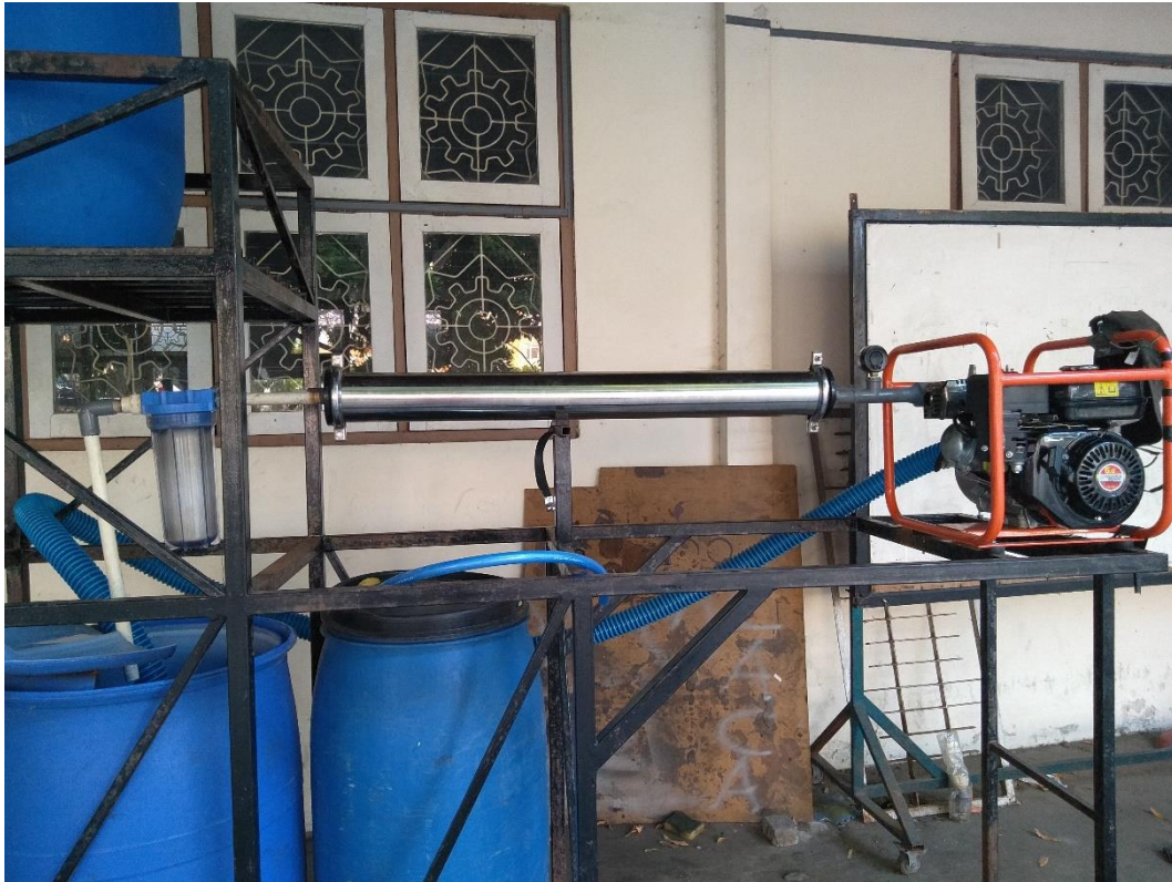
Gambar 3.6 Proses Pencucian Membran Reverse Osmosis dari Fouling
