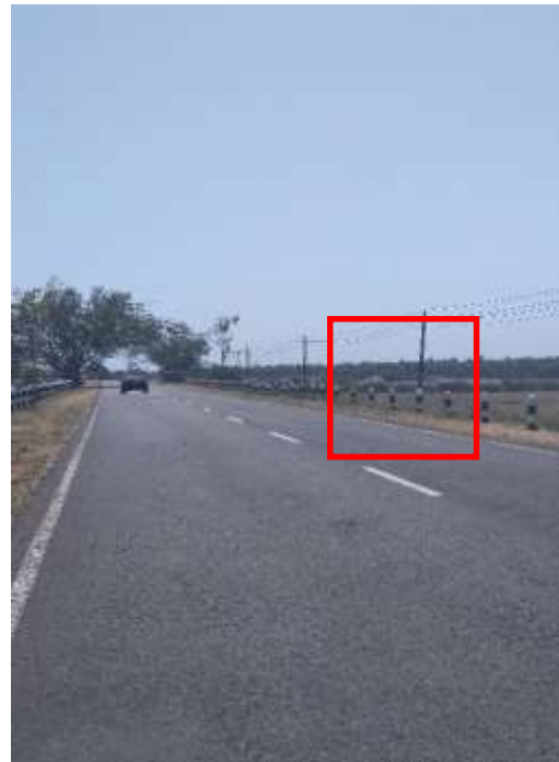
Gambar 4.12. Pagar Pengaman Tepi Jalan Hanya Berupa Balok Beton Pengaman.
