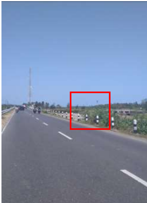
Gambar 4.12. Pagar Pengaman Tepi Jalan Hanya Berupa Balok Beton Pengaman.
