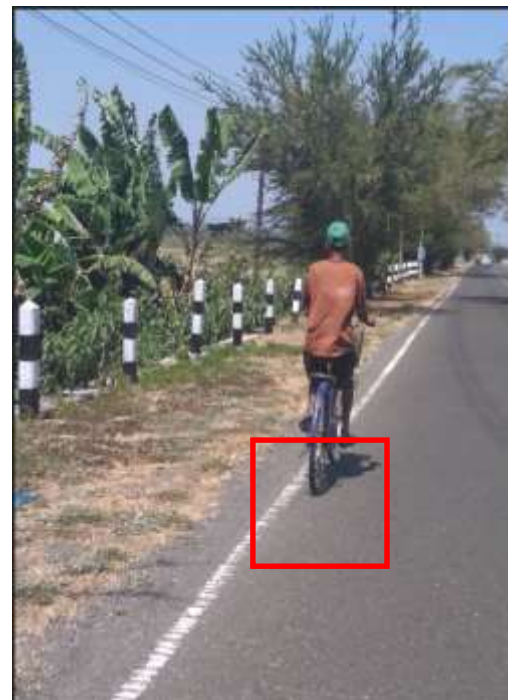
Gambar 4.11. Tidak Terdapat Lajur Untuk Pengendara Sepeda.
