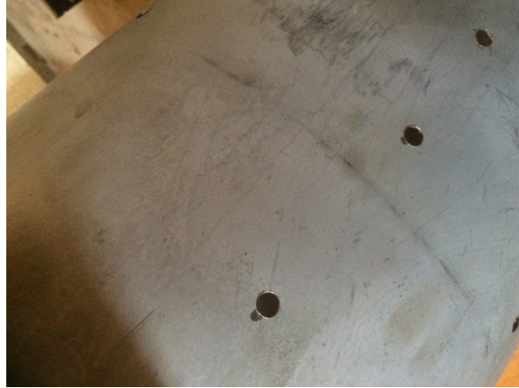
Gambar 3. 9 Lubang udara pada reaktor
