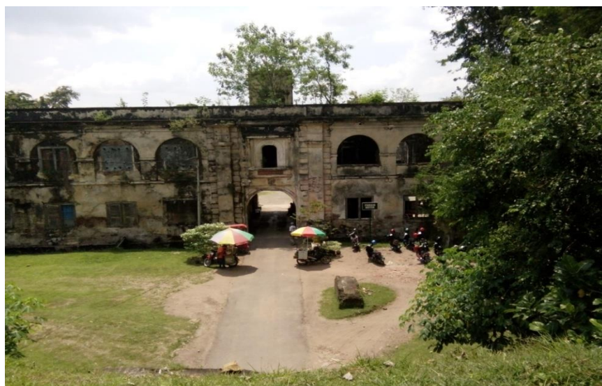
Pintu Masuk Utama
