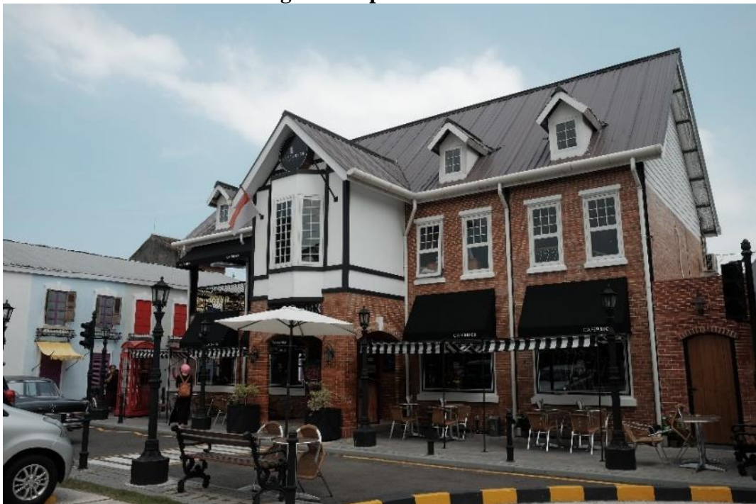
Gambar 2.1 Bangunan depan Café Brick
