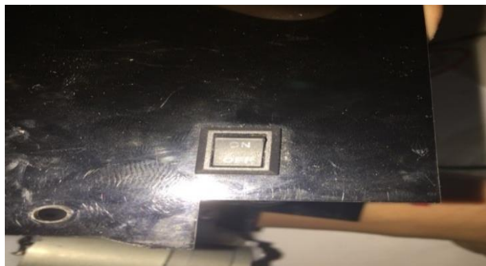
Gambar 4.28 Pemasangan Tombol On-Off .
