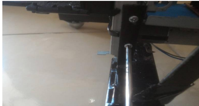
Gambar 4.42 Pemasangan Dudukan Rel Pengangkut Barang.
