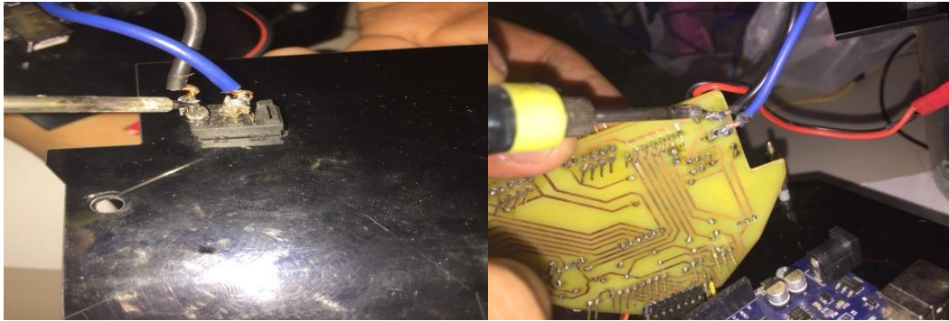
Gambar 4.29 Pemasangan Kabel On-Off Ke Board PCB.
