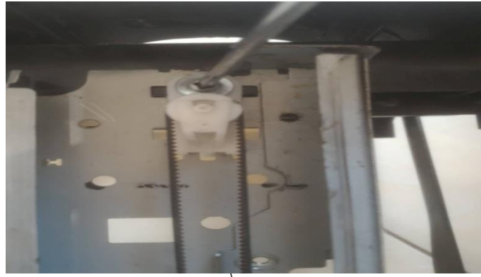
Gambar 4.44. Pemasangan Pulley dan Belt .
