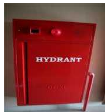
Gambar 4 Hidran gedung
