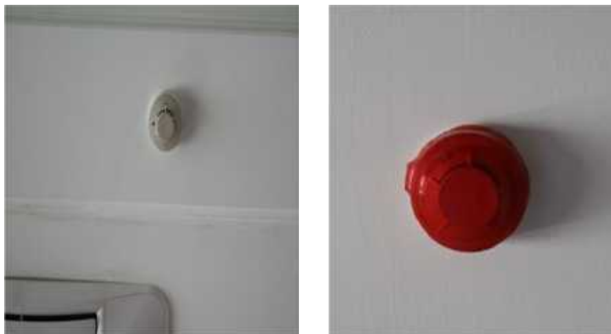
Gambar 4.13 Deteksi Asap
