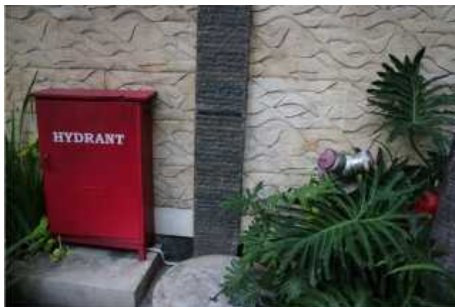
Gambar 4.5 Hidran Halaman
