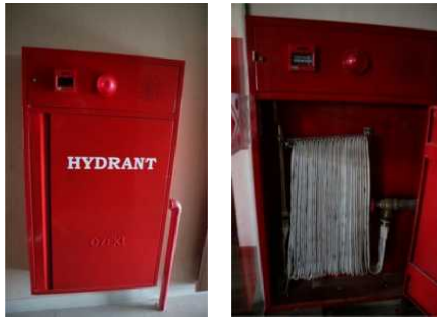
Gambar 4.11 Hidran Gedung
