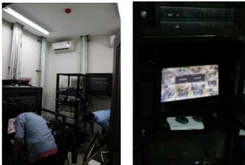
Gambar 4.16 Ruang Pengendali Operasi
